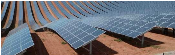
Figure 113 : Châssis s'adaptant à la topographie (Source internet)
